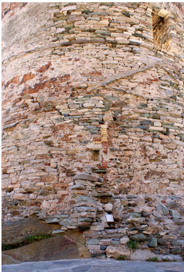
La variété des matériaux de construction et de l'appareil, source inépuisable d'observation : un détail du fort de Bonifacio. © SSC
